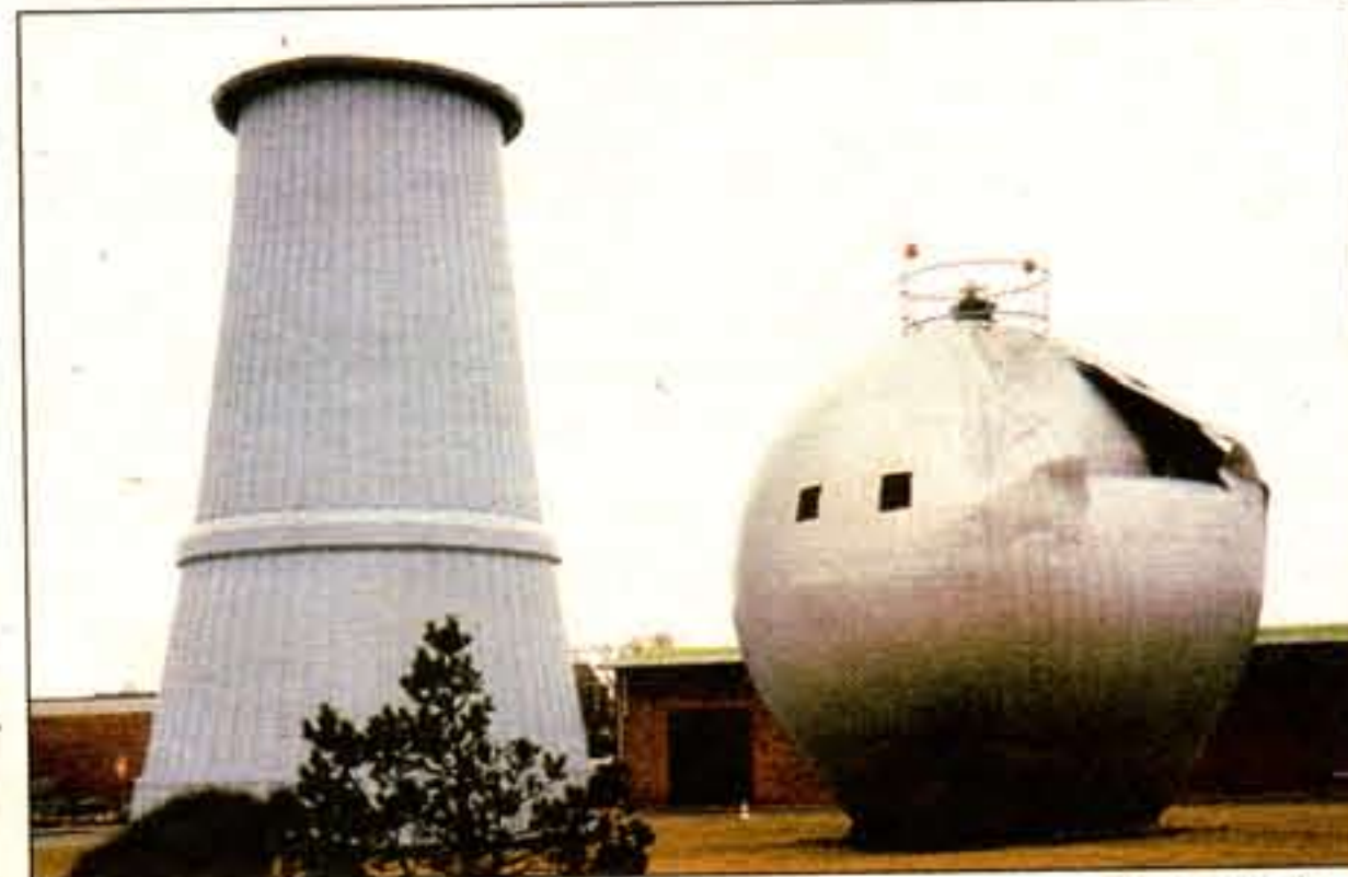
1967 hatte der Turm eine Kugel-Kuppel und 1976 eine komplette Alu-Verkleidung erhalten. Die Kugel brach 1985 nach einer Probefüllung nach innen ein und stürzte herab. 1989 wurde der Rest des Turms beseitigt. Fotos: Archiv Schmidt/hfr
