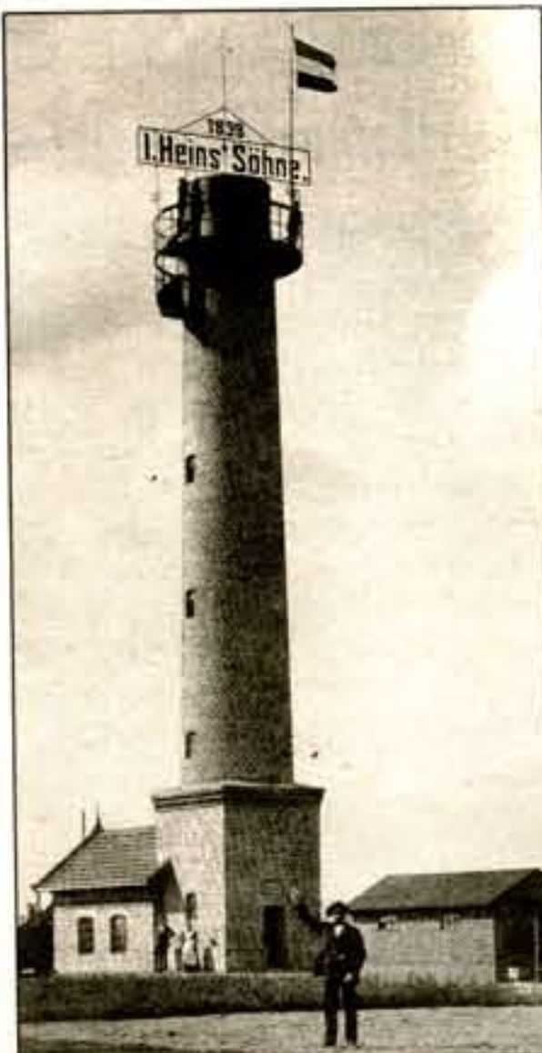
Die Forstbaumschule J. Heins' Söhne in Halstenbek besaß einen der imposantesten Wassertürme. Er wurde 1967 gesprengt. Das Foto entstand um 1900. Foto: Gabriele Schmidt Heins/hfr
