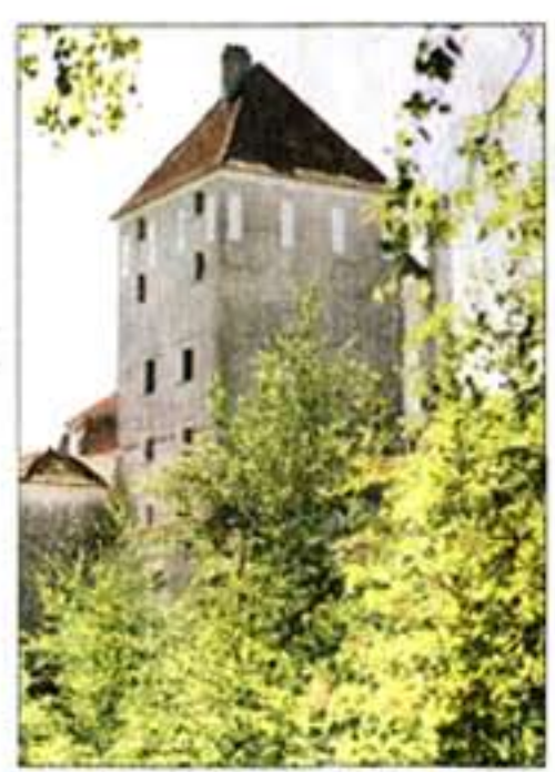
Der Wasserturm der ehemaligen Vereinsbrauerei an der Moislinger Allee ist akut vom Abriss bedroht.
