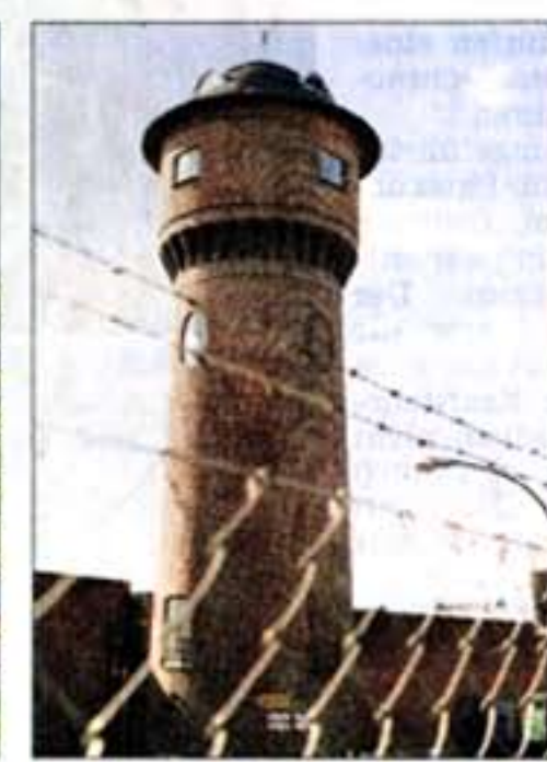
Der Turm der Lübecker Maschinenfabrik entstand bereits 1923 am Glashüttenweg.
