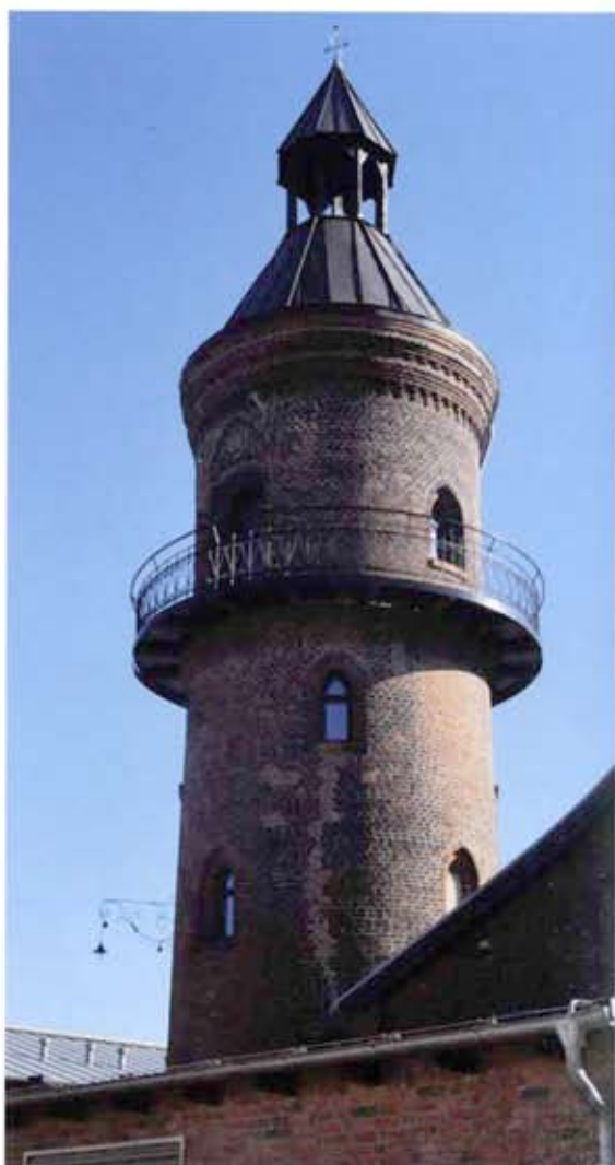
Abb. 7. Wasserturm Visselhövede (Foto Verf.).
