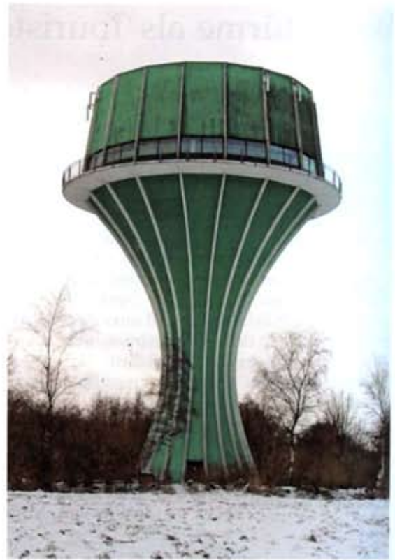
Abb. 2. Wasser- und Aussichtsturm Flensburg (Foto Verf.).
