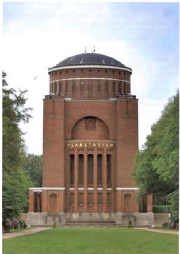
Abb. 13. Planetarium im Wasserturm Hamburg-Winterhude (Foto Verf.).
