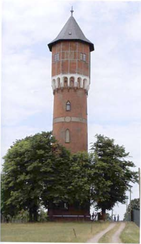
Abb. 4. Wasserturm im Neustrelitzer Ortsteil Alt-Strelitz (Foto Verf.).
