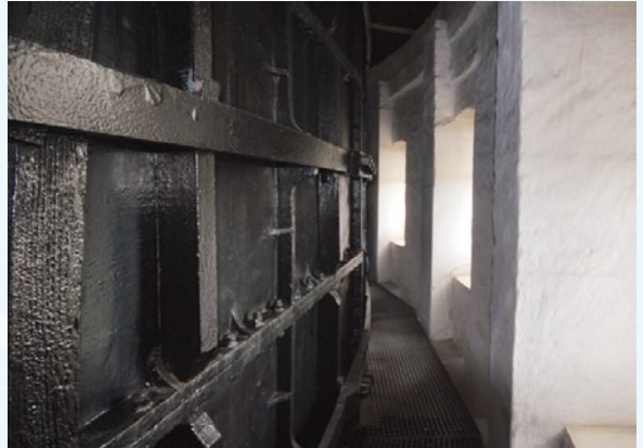
Bild 18. Behälterwandung des Zittauer Wasserturms.
