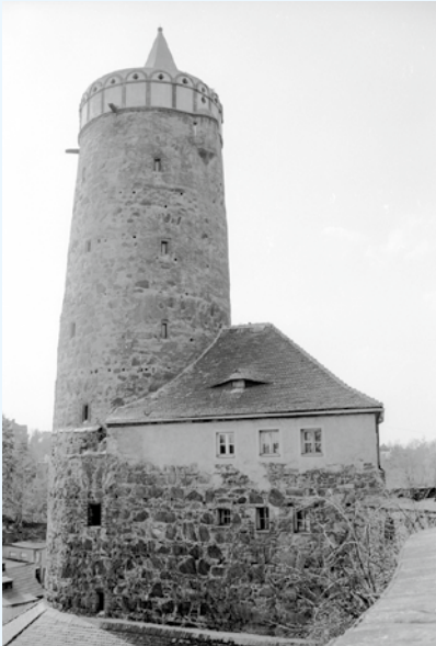
Bild 9. Wasserkunst in Bautzen.
