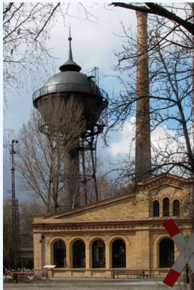
Bild 33. ▶ Klönnebehälter im Berliner Technikumuseum auf dem Gelände des ehemaligen Güterbahnhofs der Berlin-Potsdamer Eisenbahn.
