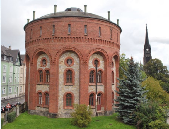
Bild 16. Wasserturm Zittau heute.
