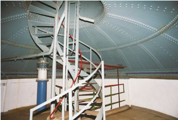
Bild 25. Boden des Intze- Behälters in Neumünster. ▼
