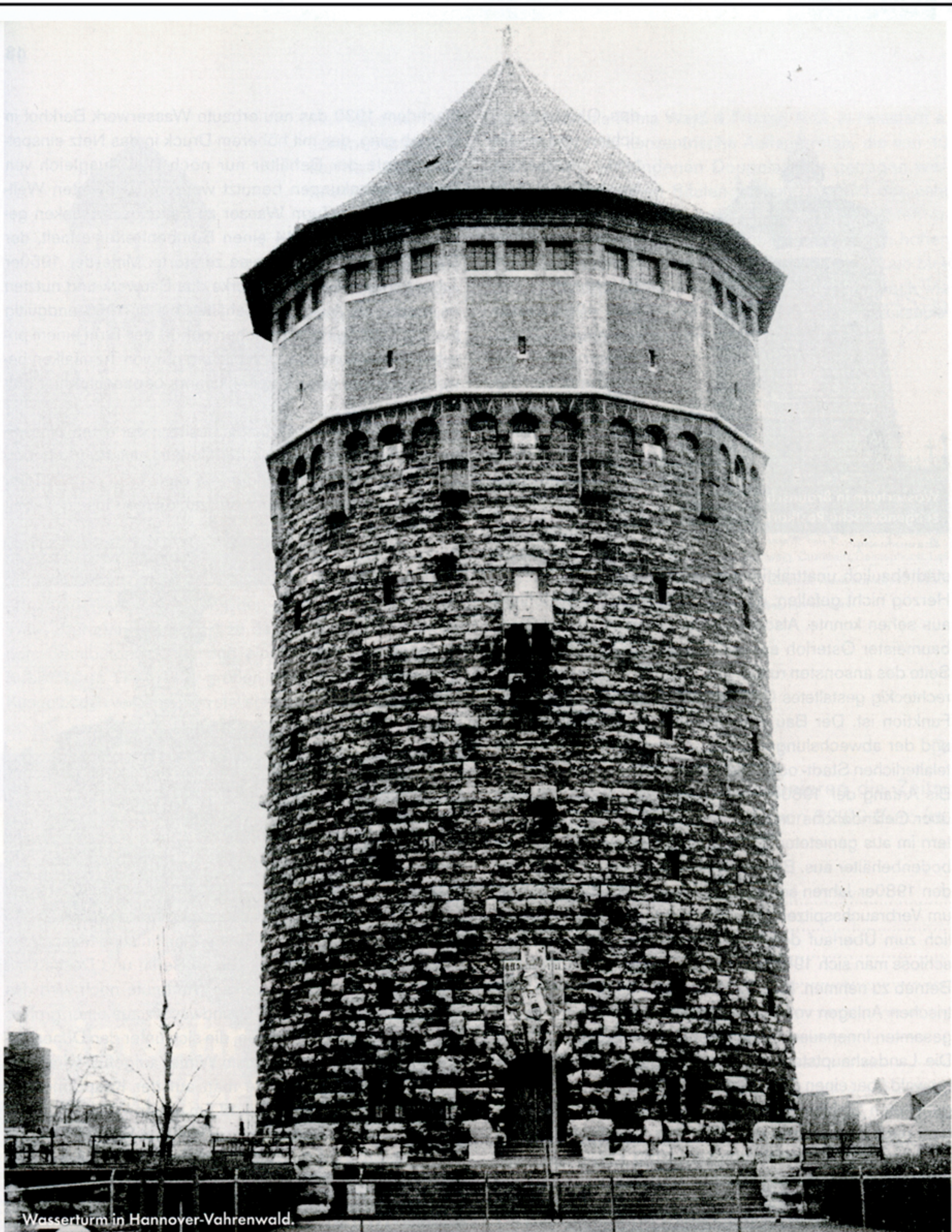
Wasserturm in Hannover-Vahrenwald.
