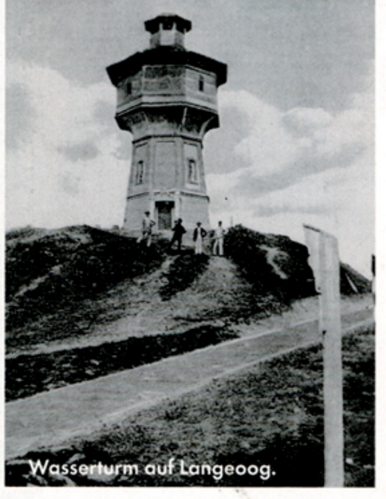
Wasserturm auf Langeoog.
