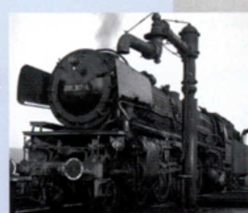
Wie in Kornwestheim gab es an vielen großen Bahnhöfen Baden-Württembergs Wassertürme zur Betankung der Dampflokotiven.
