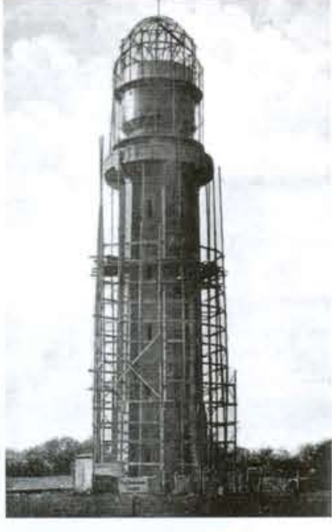
Wasserturm mit noch unverkleidetem Behälter im Jahr 1913. © Archiv Jens U. Schmidt
