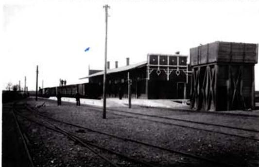
vorräte – teilweise im Schlepptender – und konnten etwa 150 Kilometer zurücklegen, ehe nachgetankt werden musste. Eine Faustregel besagt, dass eine Schnellzug-Dampflok etwa 10 Kubikmeter (entsprechend 10 000 Liter) Wasser auf 100 Kilometer benötigte. So wurden viele der kleinen Wasserstationen überflüssig. Dafür stiegen die Anforderungen an Speichervolumen und Wasserdruck erheblich. Beim Halt in einem Bahnhof musste es möglich sein, den Tender in wenigen Minuten aufzufüllen.
